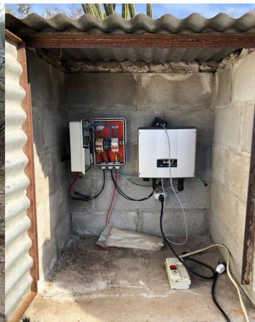
Figura 16: Estructura de resguardo con protecciones eléctricas e invertir en su interior. Fuente: Registros del colectivo La Jarilla
