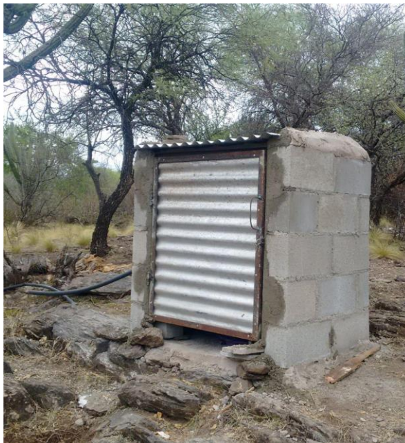
Figura 15: Estructura de resguardo de protecciones eléctricas e invertir. Fuente: Registros del colectivo La Jarilla
