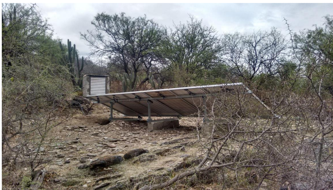
Figura 14: Vista posterior del montaje de módulos fotovoltaicos sobre bases de cemento.
