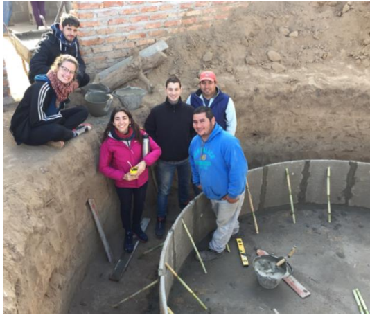
Figura 34: Colocación de primera hilera de placas (08/07/19)
