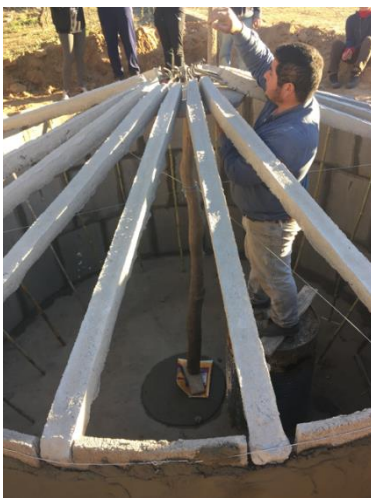
Figura 36: Colocación de vigas (08/07/19)
