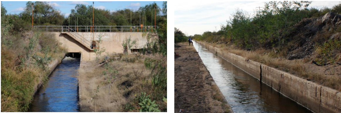
Figura 23 y 24: Margen derecho (07/07/19)
