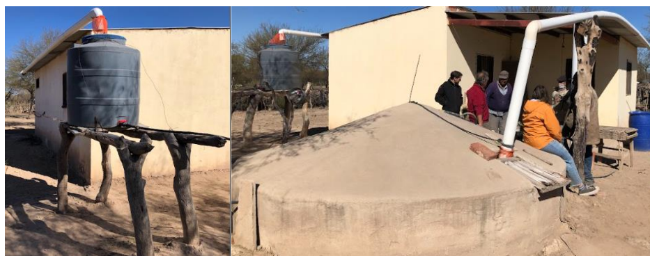
Figura 47: Tanque de plástico con prefiltro Figura 48: Cisterna 16.000 litros de Iladio con Bomba EMA (17/07/21) (17/07/21)
