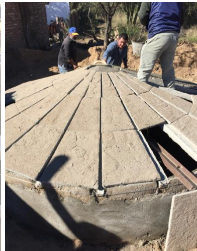
Figura 37: Colocación de placas de techo (08/07/19)
