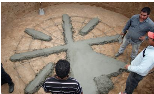
Figura 32: Armazón con hormigón (06/07/19)
