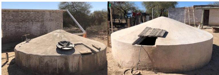
Figura 45 y 46: Cisternas 16.000 litros de Jorge O. y Agustín con Bombas EMA (17/07/21) (17/07/21)
