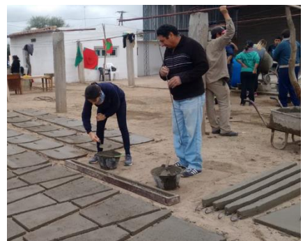
Figura 29, 30, 31: Placas laterales, vigas y placas del techo (06/07/19) Fuente: Registros del Colectivo La Jarilla
