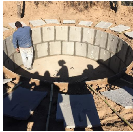
Figura 35: Colocación de segunda hilera de placas (08/07/19)
