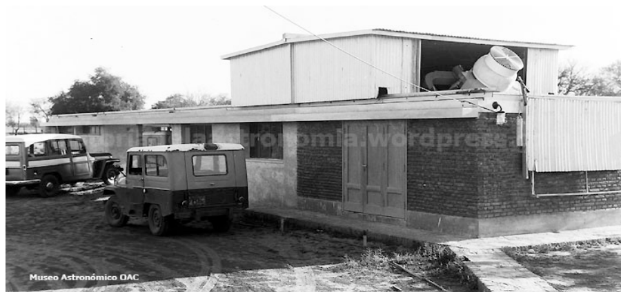
Fotografías de la estación tomadas en 1959 Y luego de su modificación y ampliación.
