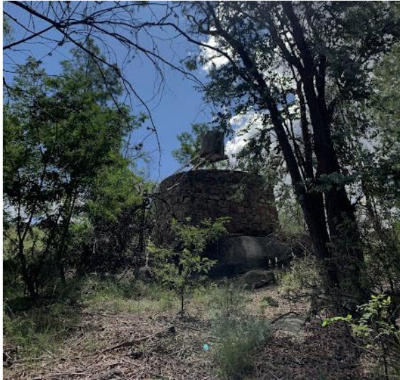
Ilustración 5 Tanque de almacenamiento de agua antiguo.
