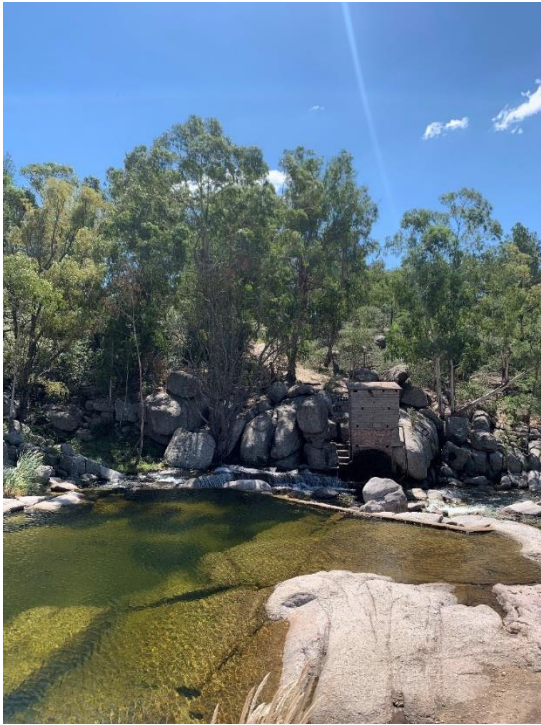
Ilustración 1: Dique de contención.
