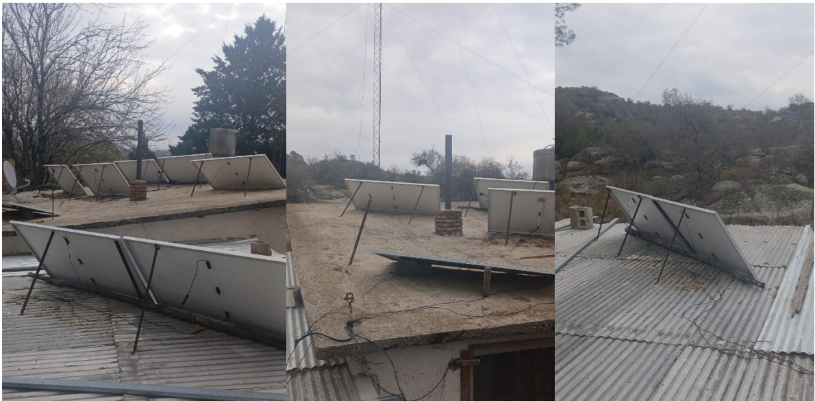
Ilustraciones 7, 8 y 9 Paneles fotovoltaicos con su respectiva inclinación y orientados hacia el N.
