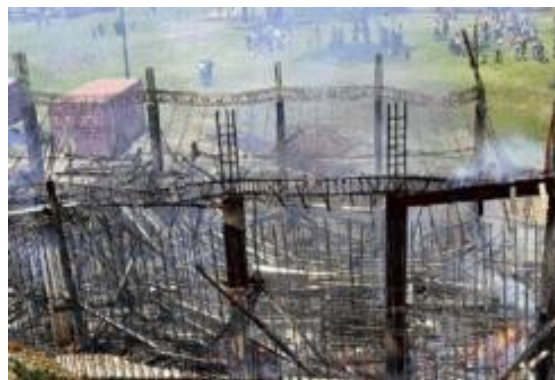
Ilustración 1. Incendio de instalaciones comerciales en el Parque de las Naciones. Fuente:
